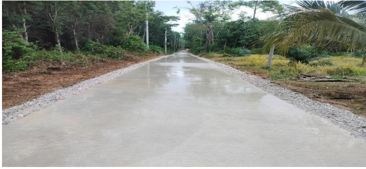
๙. โครงการก่อสร้างถนนคอนกรีตเสริมเหล็กสายอุดมสุข หมู่ ๑๒ บ้านเขาแค
